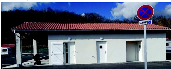
> Bureau d'accueil & Salle collective
