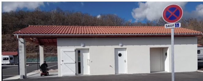
> Bureau d'accueil & Salle collective
