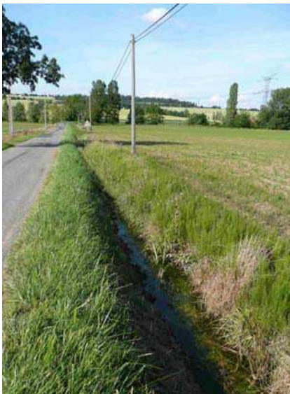
5. Fossé en eau (Verfeil - 31)
